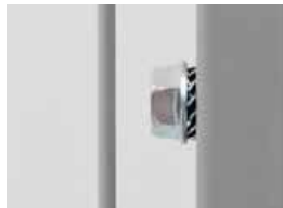
Aterramento: Conexão elétrica para solucionar as correntes de fuga
